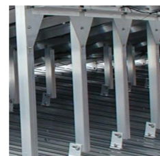
Struttura in alluminio per cambio inclinazione Aluminium structure for slope change
