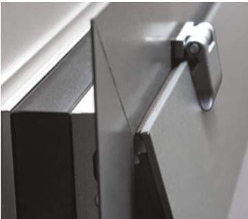
Détail rupture de pont thermique
