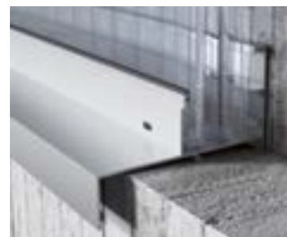
Détail du profil inférieur du mur, également disponible avec découpe par voie thermique
